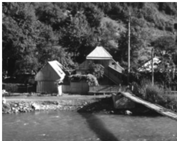
Wassertal: Siedlung mit Seilsteg
