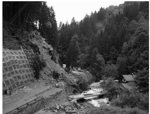
Gefährdung von Verkehrswegen durch Hangrutschungen. (Foto G. Heißel)
