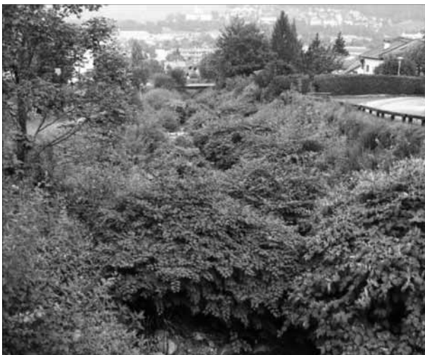
Bewuchs im Bachbett stellt ein potentielles Risiko für den Hochwasserabfluss dar. (Foto S. Sauermoser)
